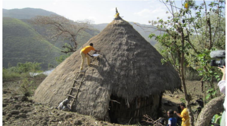
Installation eines Solarmoduls in Arso Amba
